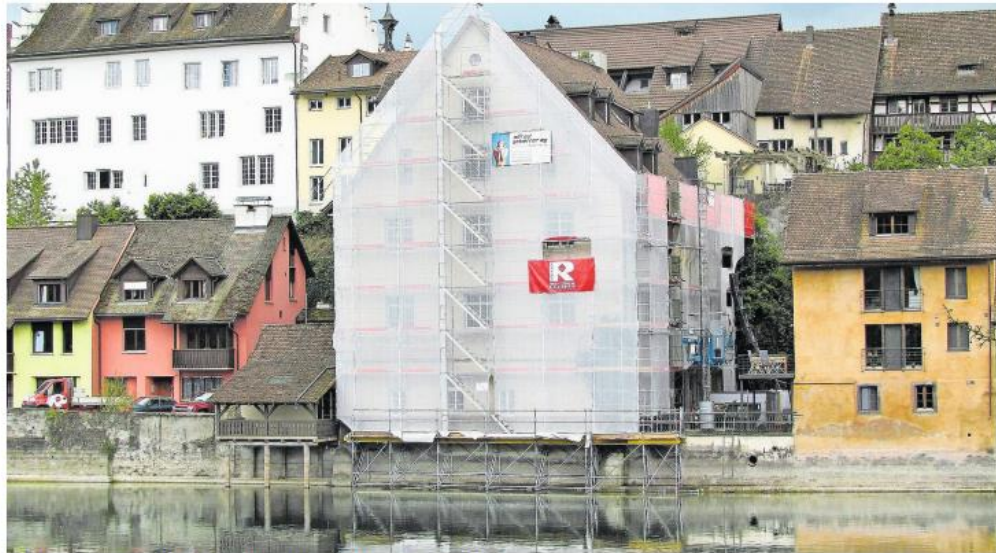
Das Toggenburgerhaus ist für die Renovation fast komplett eingerüstet
