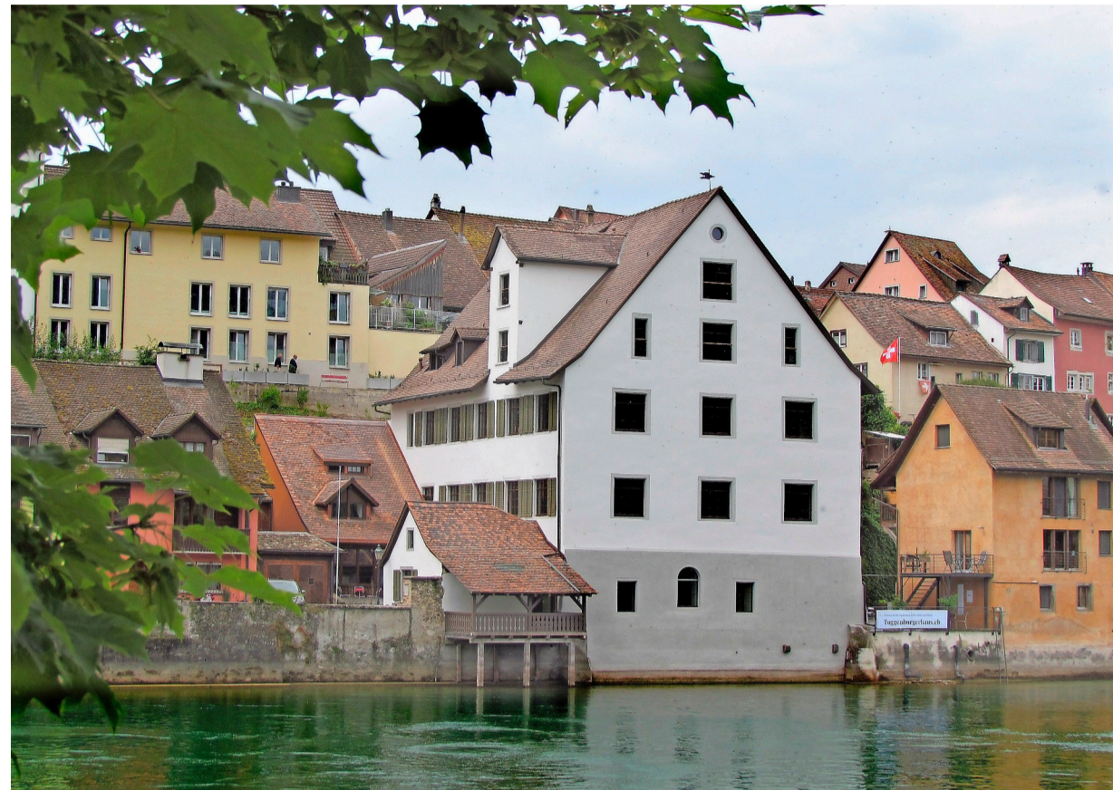
Das Toggenburgerhaus wurde während 15 Monaten aufwendig saniert.
